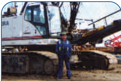
AGRA FOUNDATIONS SUNCOR FIREBAG
